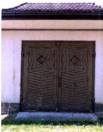
Waschhaus, Detail Garagentor. [Fotografie MEC 2014]
