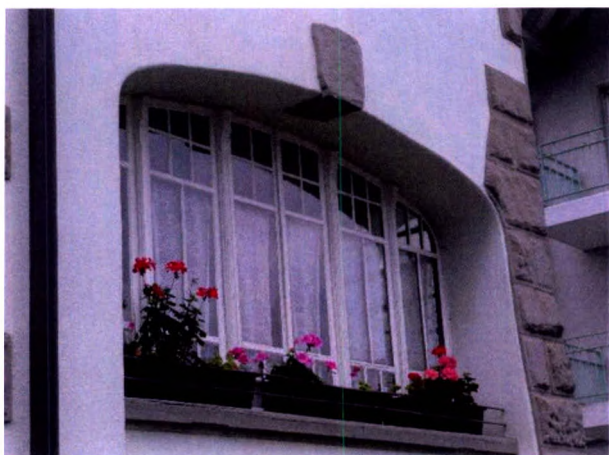
Uznacherstrasse 7, Detail Nordfassade. [Foto MEC 2014]
