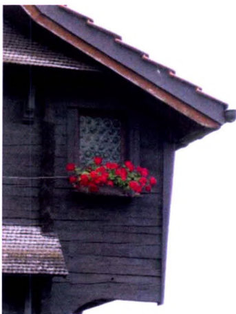
Strassenseitige Hauptfassade, Detail Laube. [Foto MEC 2014]
