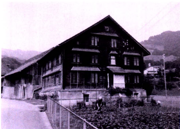
Bauernhaus Wiedenstrasse 5 mit rückwärtig angebau- ter Stallscheune.
