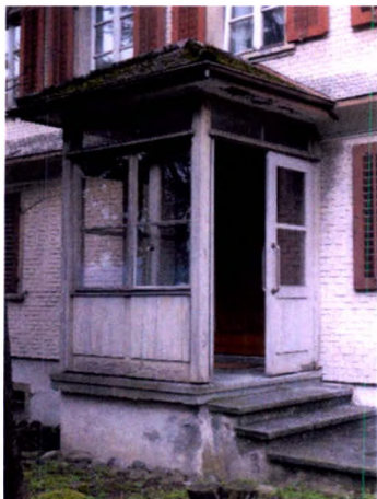
Hauseingang mit Windfang. [Foto MEC 2014]
