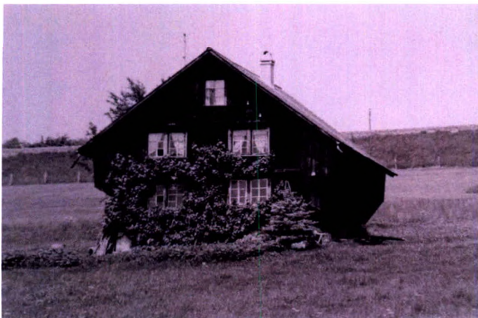
Gjuch 343, Zustand vor dem Umbau 1978. [Foto Ortsbildinventar 1977]
