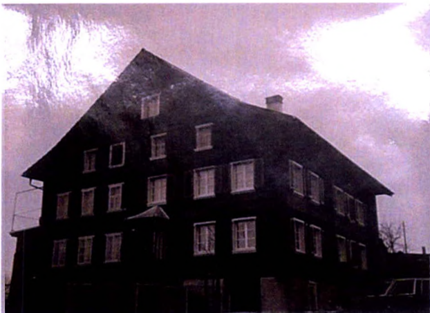
Bauernhaus Gasterstrasse 88, Zustand vor der Restaurierung 1978.
