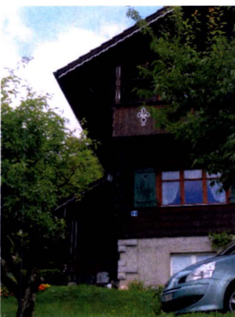
Südwestlicher Hausbereich. [Foto MEC 2014]
