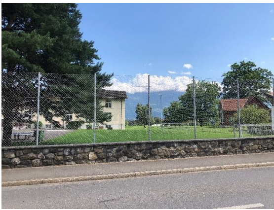
Kantonstrasse, in Fliessrichtung Richtung Schule, Bach eingedolt
