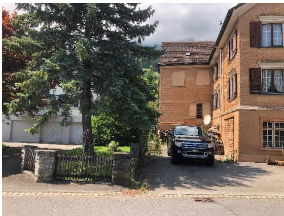
Kantonstrasse, gegen Fliessrichtung, Bach eingedolt
