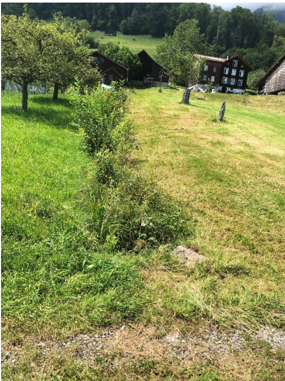
Durchlass, Blick aufwärts, km 0.510
