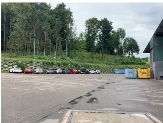
Erschliessungsfläche mit best. Stützmauer
