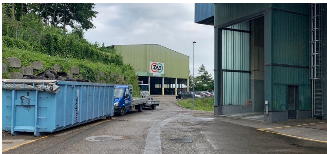
Abb. 11: Bestehende Stützmauer im Bereich mit Waldabstandsunterschreitung und künftige Durchfahrt zu P-Rückgewinnung (Quelle Atelier Bottlang)
