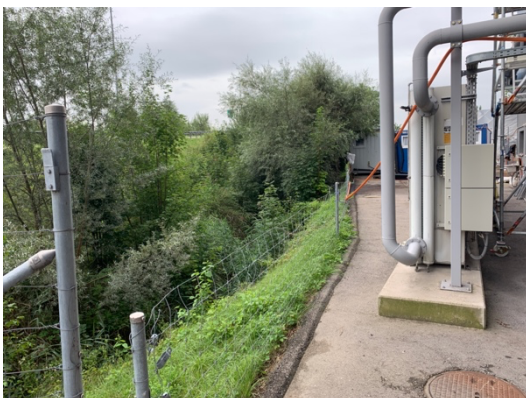
Grünfläche im Gewässerraum Rütelisbach
