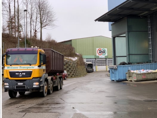
Zufahrt zwischen KVA und zu ersetzender Lagerhalle
