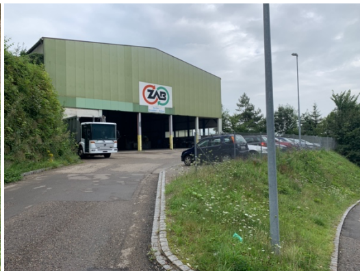
Geländesprung zwischen Lagerhalle und Zufahrt UG KVA.
