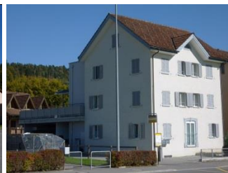
Objekt ohne Einstufung
