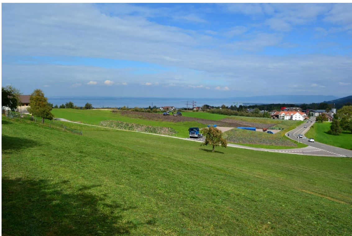
Abbildung 9.2: Betriebszustand der Deponie - Blick vom Alberenberg in Richtung Nord-Osten (Zustand ca. 2 Jahren nach Betriebsbeginn (Phasen II und III der Etappe 1 in Betrieb))
