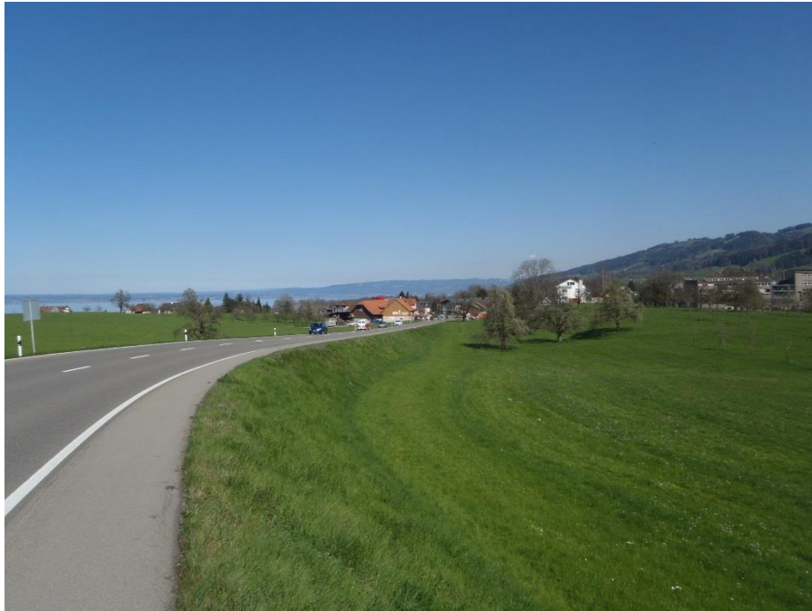
Anhang C. 5: Blick von West nach Ost auf Südböschung Strassendamm
