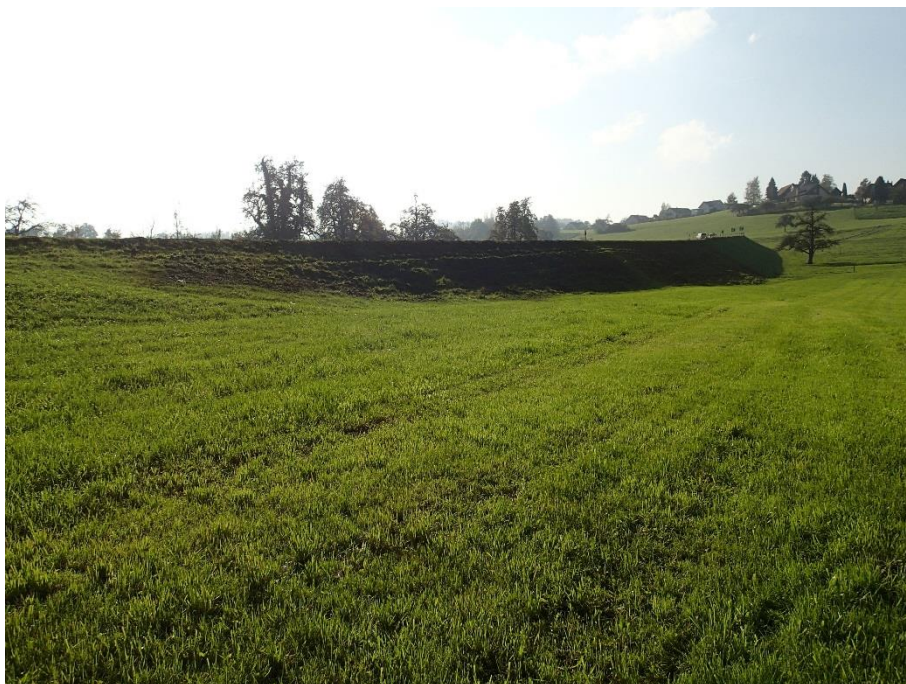
Anhang C. 4: Blick von östlicher Taanstr. auf Nordböschung Strassendamm
