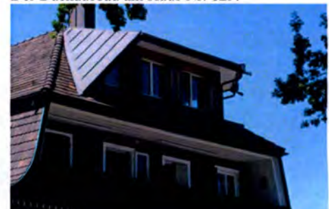
Der Dachausbau am Haus Nr. 629.
