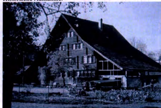
Das bild zeigt das Haus 1975 während der Restaurierung durch die jetzigen Besitzer Josef und Esther Eugster.
