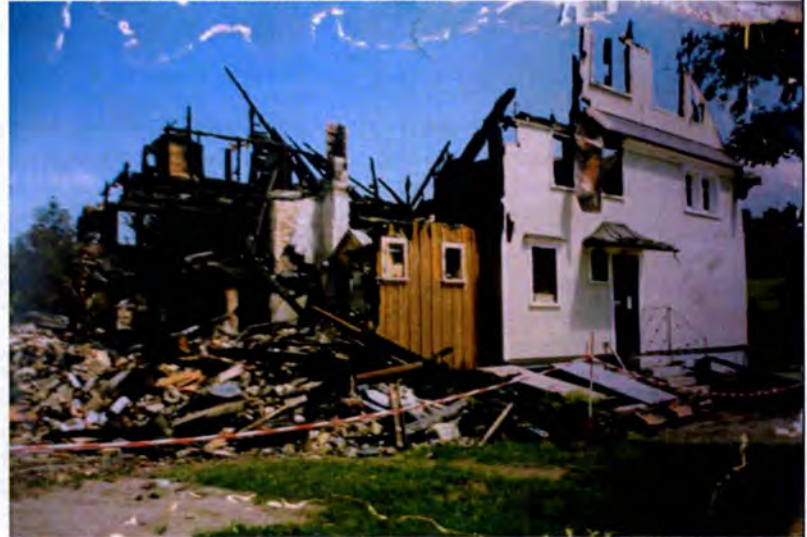
Ein Brandfall von 1991 zerstörte das Haus 4:
